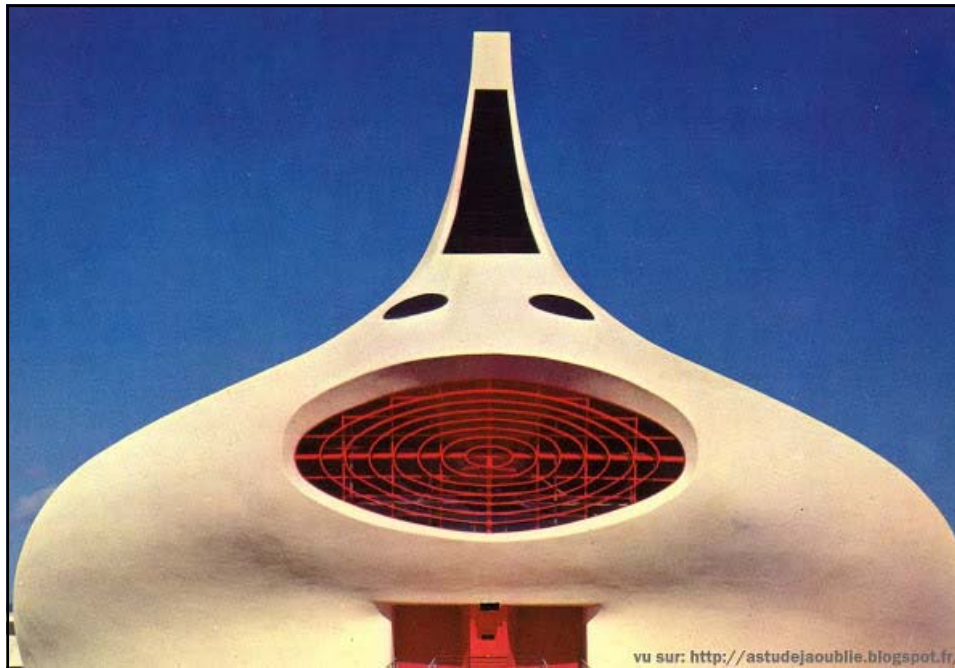
Ohbayashi-Gumi (Architekt): Gas Pavilion.
