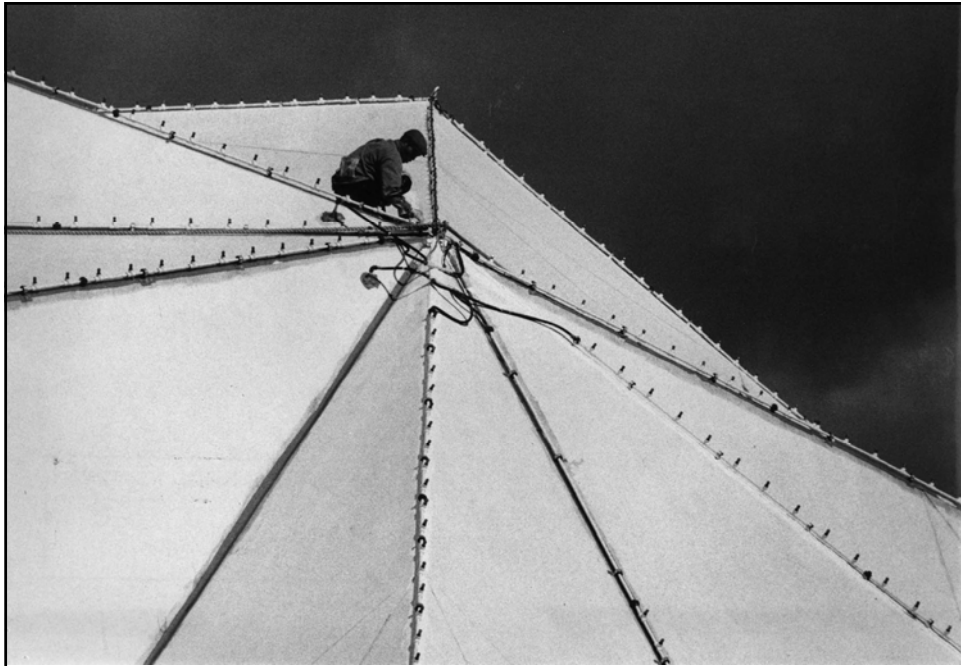
Installation der Düsen für die „Fog Sculpture“ an der Außenhaut des Pavillons.
