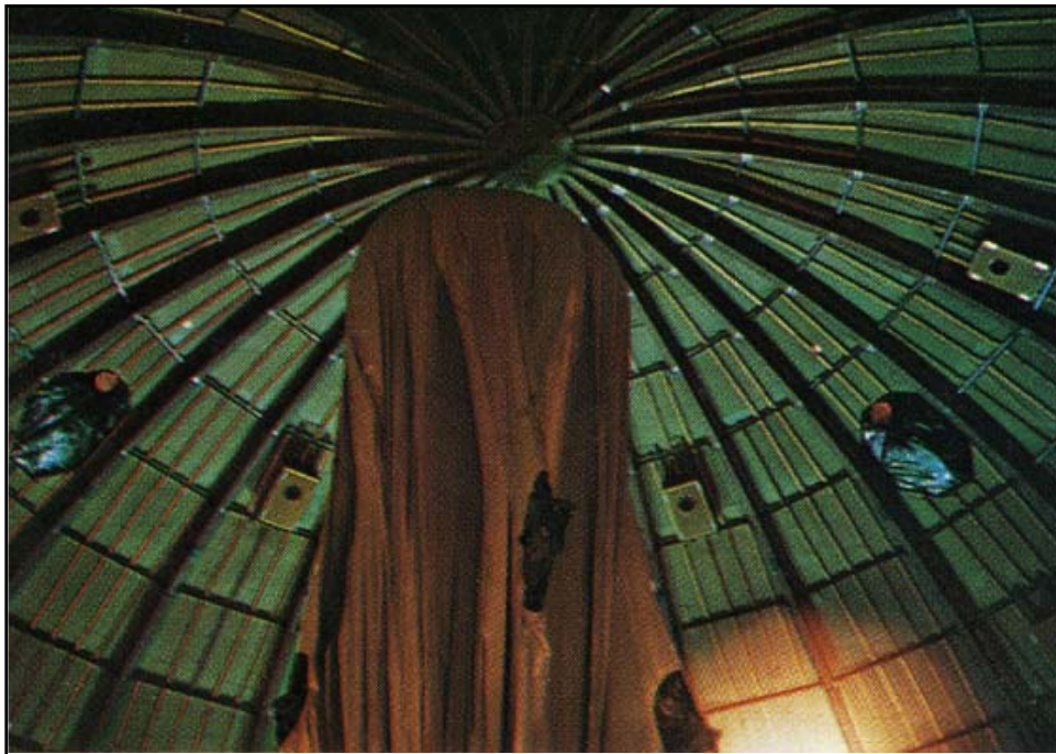
Aufbau des Spiegeldomes, mit Gerüst und Ansaugvorrichtung.
