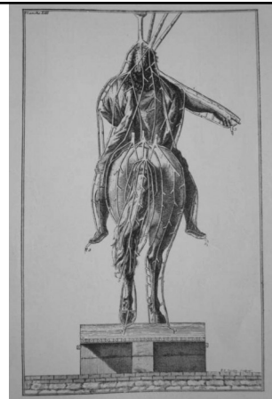
Verteilung der Einguss- und Entlüftungskanäle und Wachskanalisationen, Profil der linken Seite.
