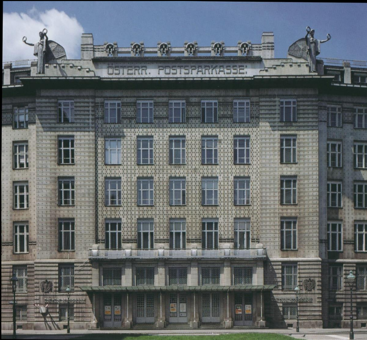
Otto WAGNER, Postsparkasse, Georg- Koch-Platz, Wien, Extérieur. Façade. Fines plaques de marbre fixées au béton armé par des boulons apparents en aluminium, 1904 - 1906 / 1910 - 1912
