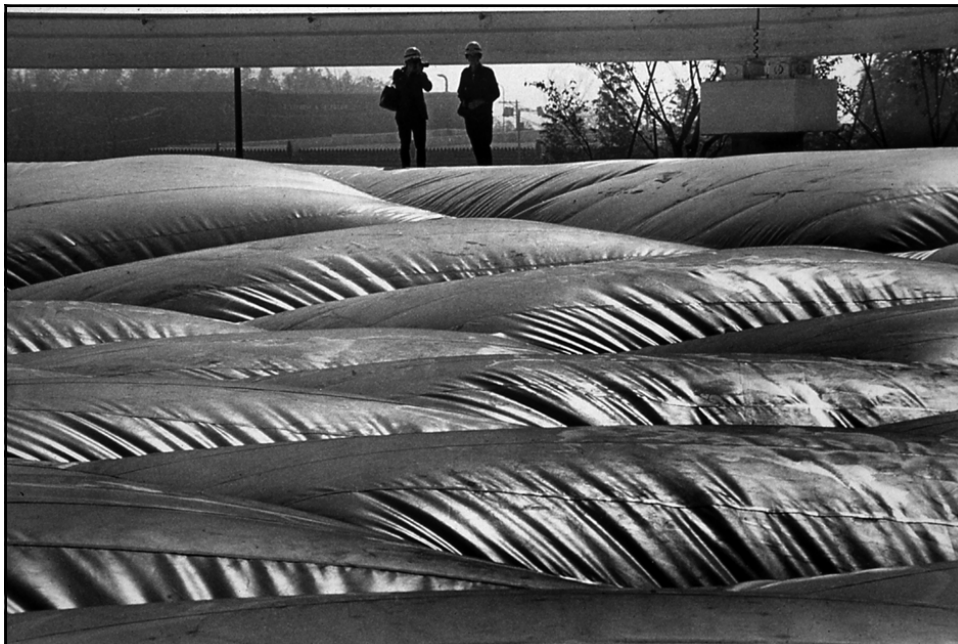
US Pavillon, Expo 70, Osaka. Dachstruktur.
