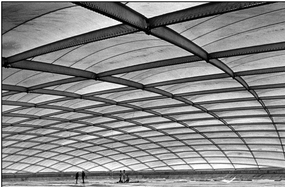
US Pavillon, Expo 70, Osaka. Dachkonstruktion, Innenansicht.
