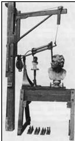
Punktiermethode, hier zur Vergrößerung verwendet.
